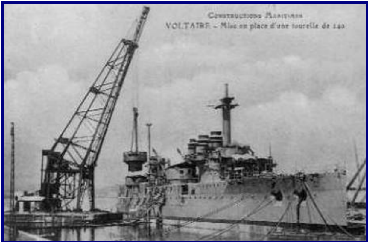
Constructions maritimes. VOLTAIRE – mise en place d'une tourelle de 240.
